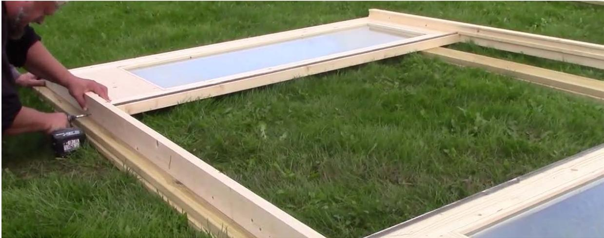
Zwei Spezial-Profile aus Metall für das spätere Einhängen der Türen müssen im oberen Rahmen mit Schrauben angebracht werden (4 Schrauben pro Profil). Beide Spezial-Profile müssen zugeschnitten werden.
